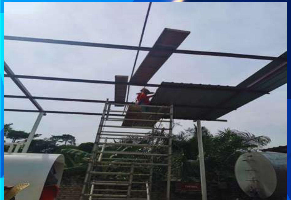
Pemasangan Bumbung Tangki Petrol & Diesel
