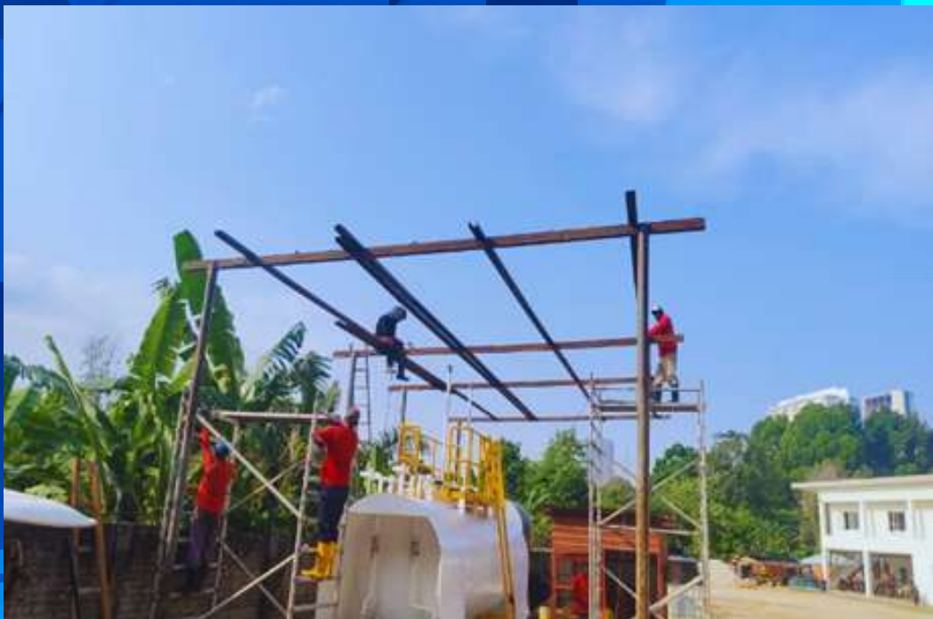
Pemasangan Bumbung Tangki Petrol & Diesel
